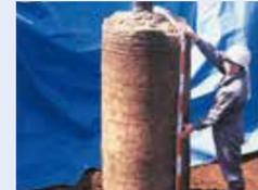
コラムと羽根つき鋼管の合体で大きな支持力
