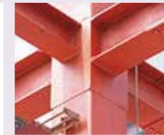
ノンダイアフラム形式の柱梁接合工法
