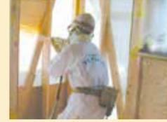
水で発泡させる硬質ウレタン断熱材
