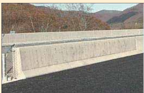
橋梁地覆・面壁
