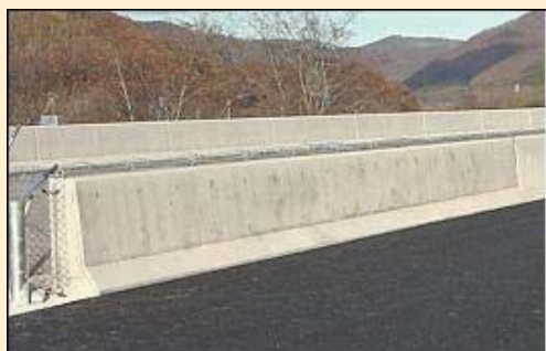
橋梁地覆・面壁
