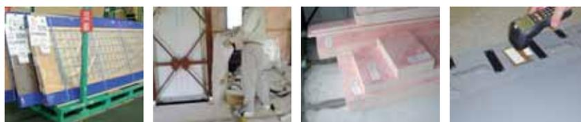
リターンブル梱包された部材 新築材の分別 部材のプレカット(断熱材) ICタグでリターンブル梱包材管理
