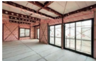
鉄骨とヘーベル版だけの状態にしてからのリフォーム
