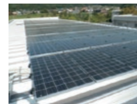
K棟太陽光発電パネル
