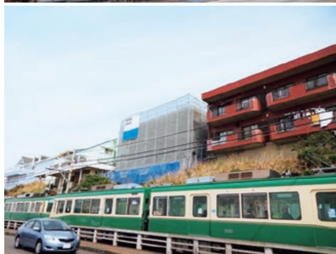
新イメージシート設置現場
