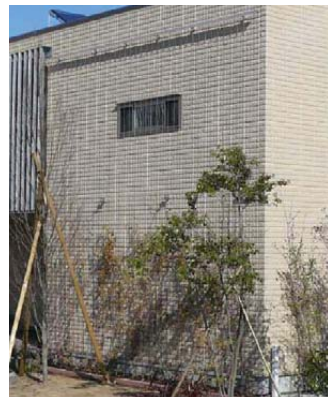
西日による壁の蓄熱を抑える西面の緑のカーテン
