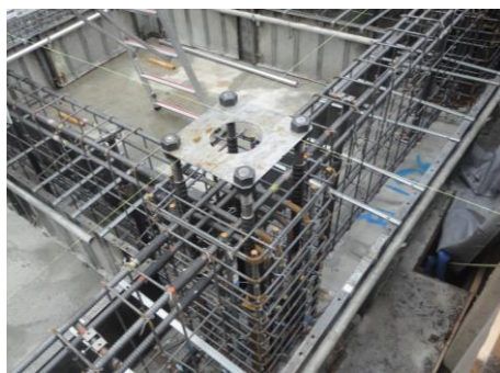
「工場先組み鉄筋」
