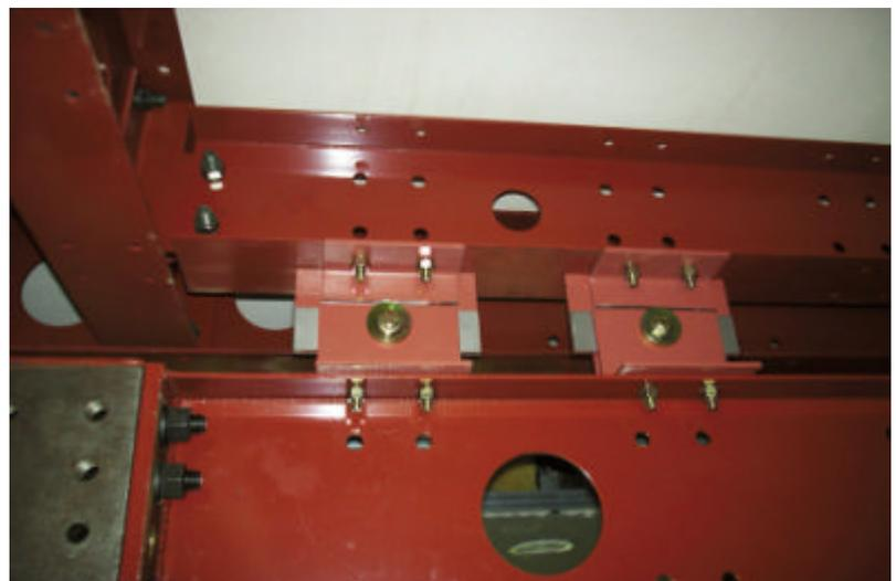
・ダンパーフレームと構造体を繋ぐ摩擦ダンパー
