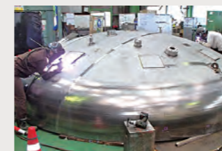
消防法タンク製作
