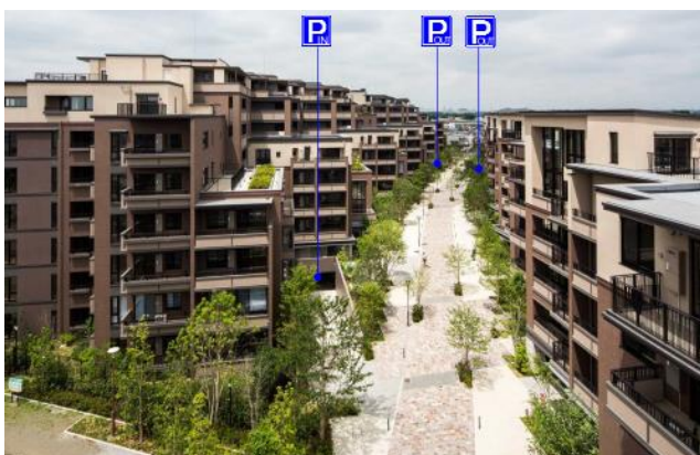
マンション駐車場を地下化し出入口を建物端部に設けることで、コミュニティ道路には居住者自身の車さえも侵入を抑制するよう配慮。
