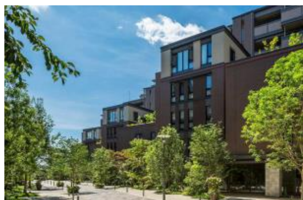
分譲マンションはコミュニティ道路を挟んで雁行形式とし、3面開口を持つ住戸やメゾネット住戸によるリズムある風景。
