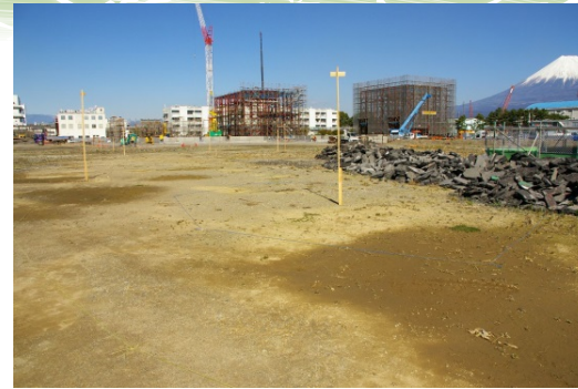
同時期の「あさひ・いのちの森」予定地。盛り土の高さを表す杭が打たれている
