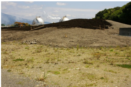
2007年4月初旬。現地発生土の地盤の上に客土が進んでいる
