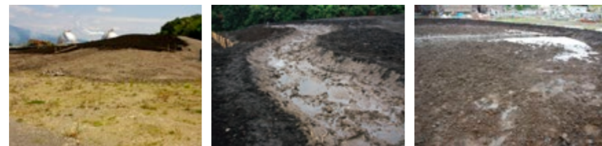
2007年4月初旬。現地発生土の地盤の上に客土が進んでいる 2007年4月下旬。浮島ヶ原の表土が客土された流れ部分 2007年4月下旬。造成された水田盤
