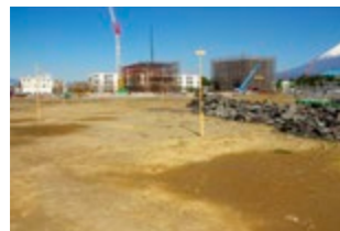
同時期の「あさひ・いのちの森」予定地。盛り土の高さを表す杭が打たれている
