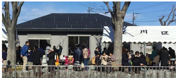
分譲地内に建設し地域へ寄贈したヘーベルハウス平屋建ての集会所。 太陽光・蓄電池などエネルギーの自立機能を備え、地域の防災拠点として利用。
