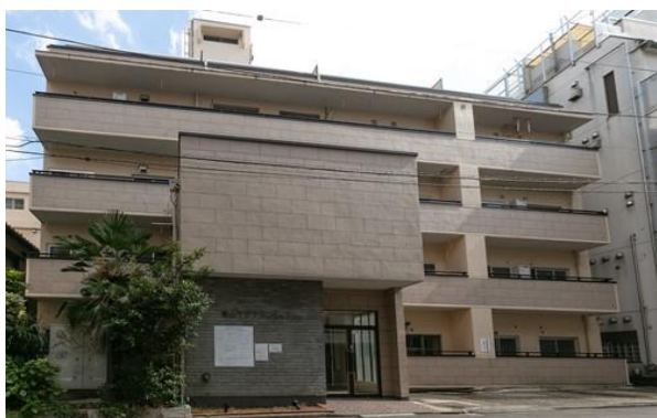
従前建物の外観
