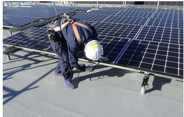
システムを利用した作業風景
