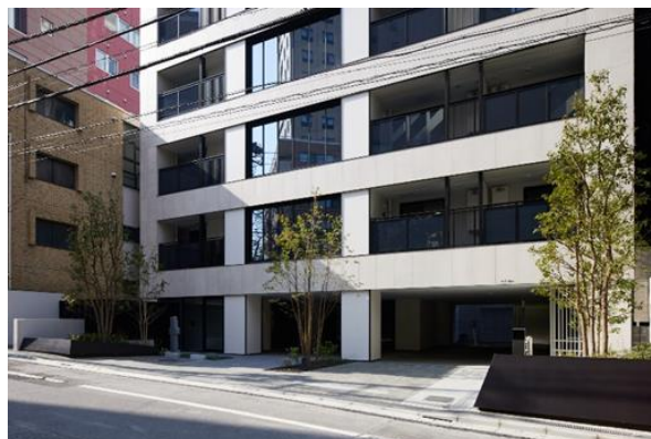
エントランス正面外観
