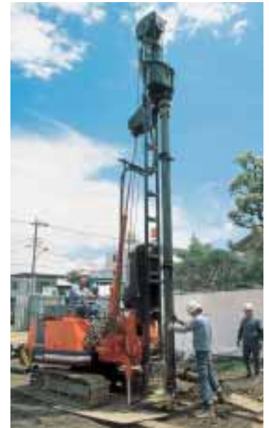
軟弱地盤に強い「ASWパイル」施工風景
