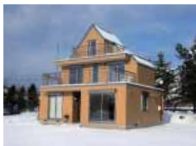
ヘーベルハウス白老実験棟外観
