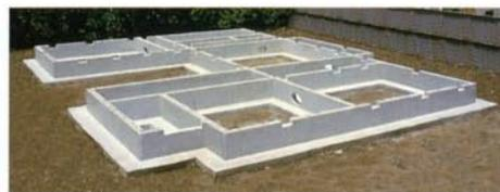
不同沈下が生じにくい鉄筋コンクリート連続布基礎
