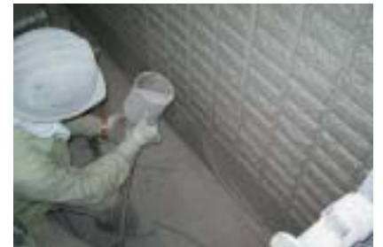
中塗り層と上塗り層の現場吹き付け
