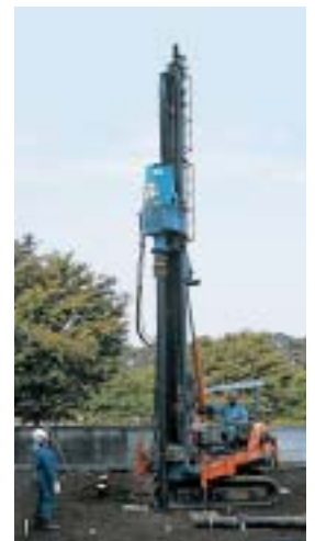
「EAZETパイル」施工
