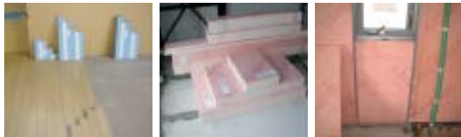
部材のプレカット(左: 寄木合板、中央・右: 断熱材)
