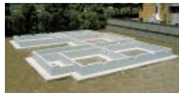
不同沈下が生じにくい鉄筋コンクリート連続布基礎
