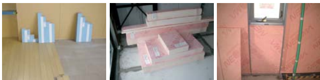
部材のプレカット(左:寄木合板、中央・右:断熱材)
