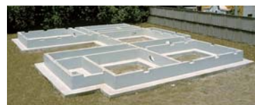
不同沈下が生じにくい鉄筋コンクリート連続布基礎
