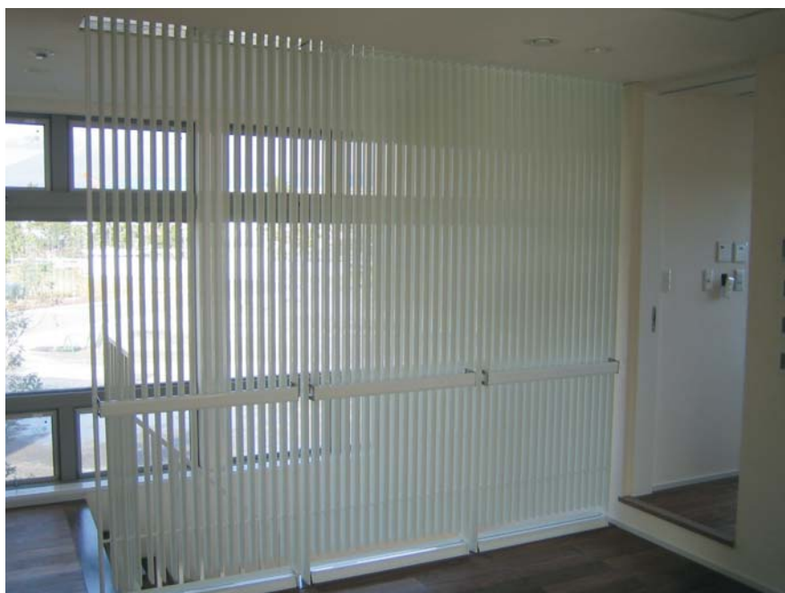
地中熱を利用した冷暖房放射パネル
