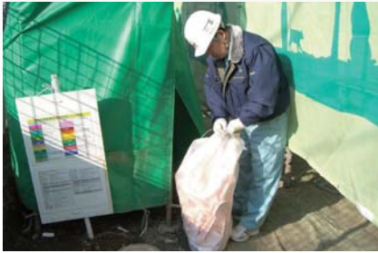
施工現場での分別作業
