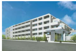
全国で初めてマンション建替え円滑化法により建て替え組合の設立が認可された諏訪町住宅
