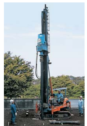
「EAZETパイル」施工(杭工法)
