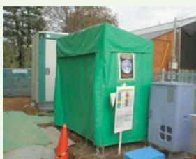
施工現場の廃棄物保管場所
