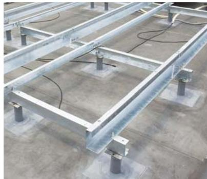
ヘーベル版に固定した柱脚に架台を設置。自由度の高い設置が可能
