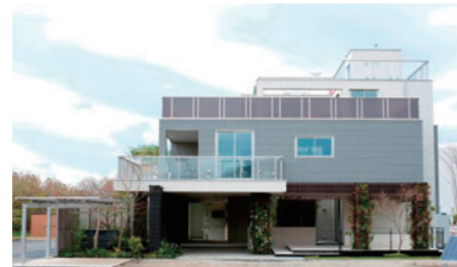
実証棟HH2015外観
