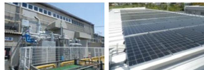
ガスコージェネレーションシステム K棟太陽光発電パネル
