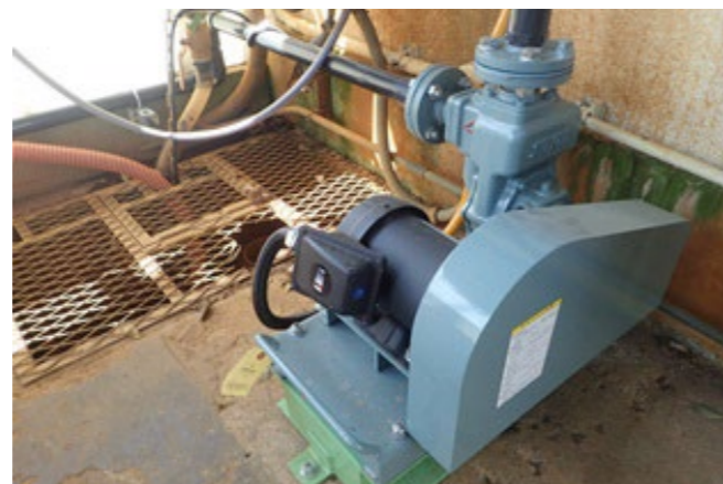
排水処理場 凝集汚泥返送ポンプ
