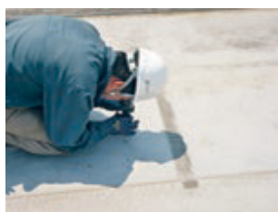
認定点検技士による定期点検
