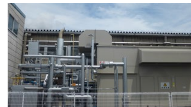
ガスコージェネレーションシステム
