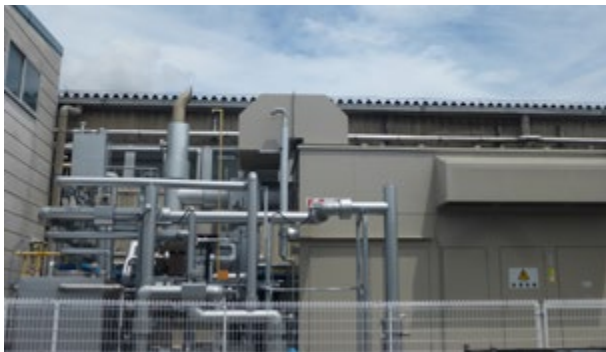
ガスコージェネレーションシステム
