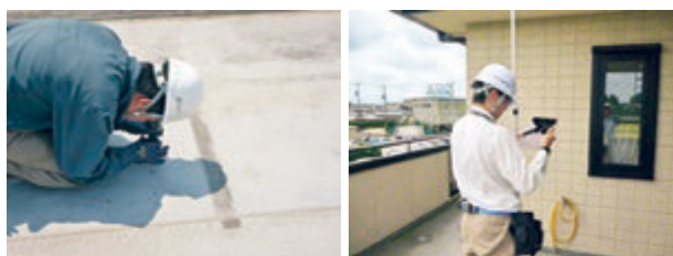
認定点検技士による定期点検
