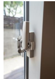
ストッパー付きクレセント+ サブロックによる二重ロック
