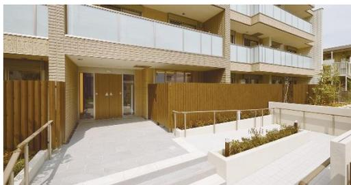
階段は段差の色を分けて視認性を高め、転倒・つまづきのリスクを軽減。階段がつかなくても通行しやすいようスロープを設置。
