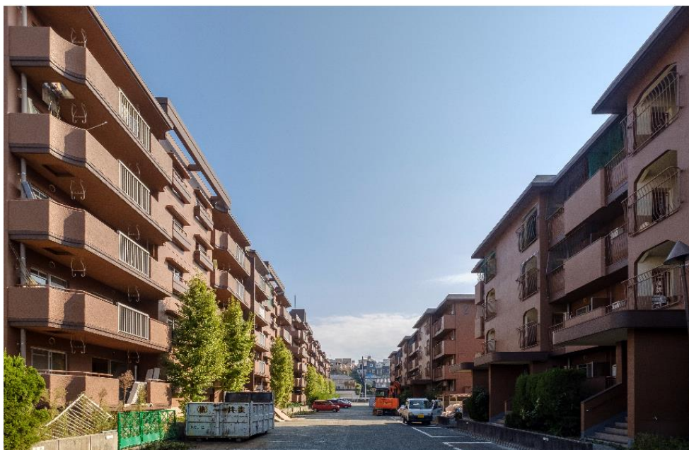
被災した「上熊本ハイツ」(2017年9月解体前撮影)
