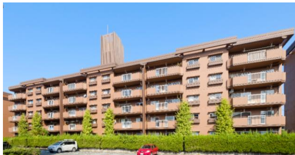
最も傾斜が大きかった 4 号棟、杭が損傷したことで建物が傾斜
