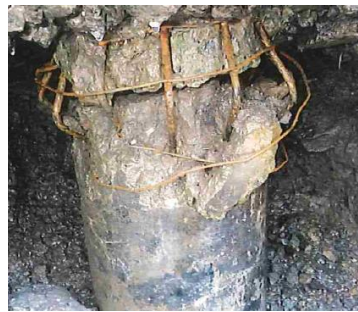
調査時の 3 号棟の杭の様子
