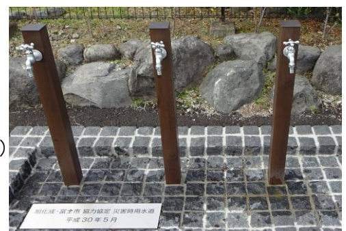
非常時に使用できる地下水
