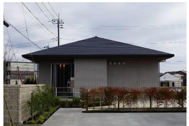
完成した「江川区集会所」外観写真
