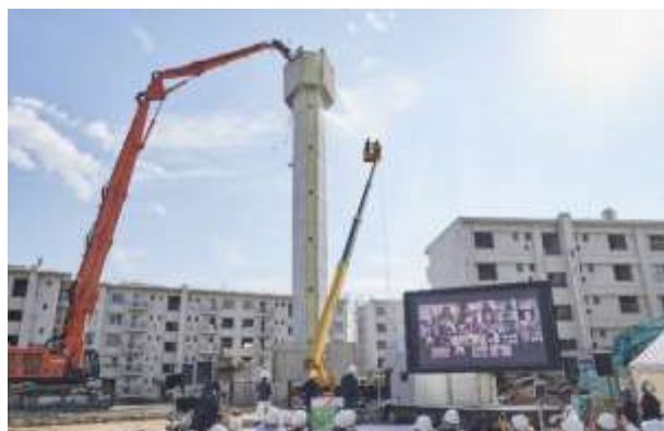
団地のシンボルでもあった給水塔解体開始の風景
