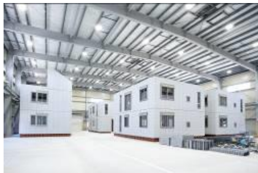
手前には基礎・鉄骨研修スペースを配置
