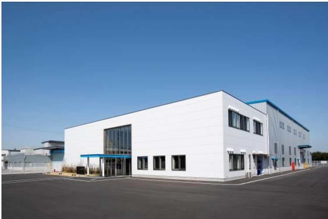
施設外観:手前側に研修棟、奥側に実習ゾーンを配置
