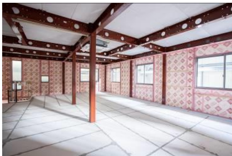
建物内部では木工事研修などを実施
