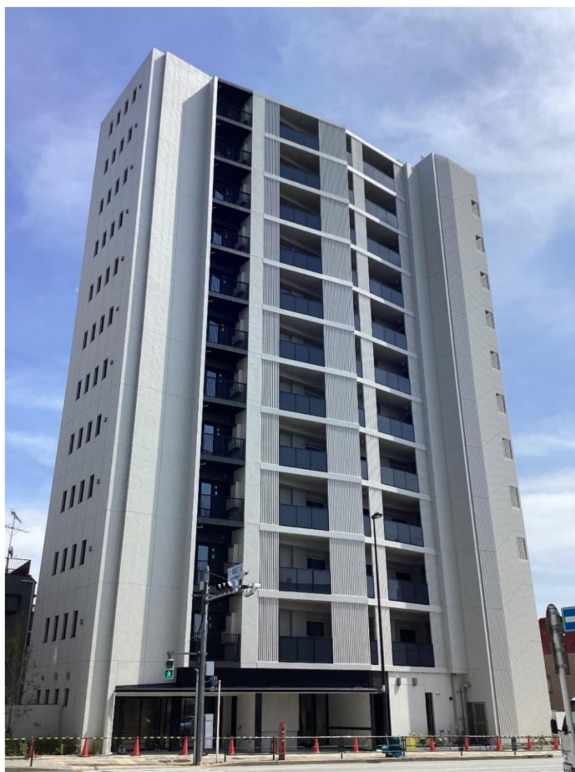
事業竣工外観
