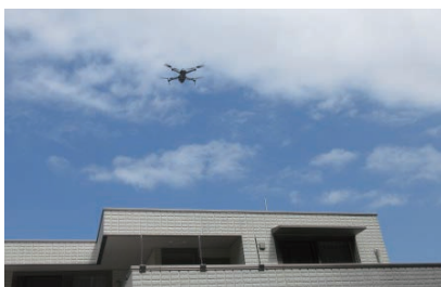
勾配系屋根や太陽光パネルの確認をドローンカメラにて実施（一部エリアではドローンカメラ未導入）
