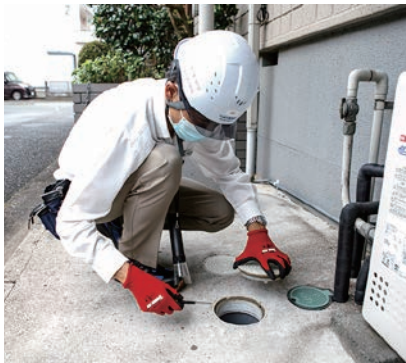
認定点検技士による定期点検
