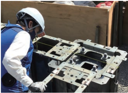
基礎工事の品質検査
