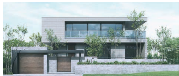
「HEBEL HAUS RATIUS | RD」外観
