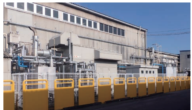
ガスコージェネレーションシステム1号機
