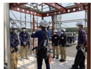
鉄骨建方実技研修
