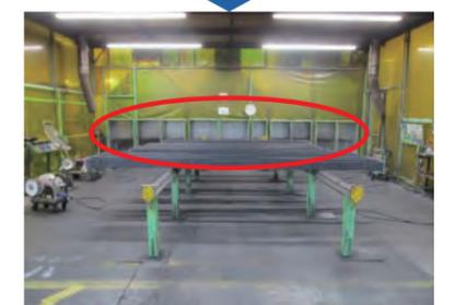
改修後の集塵機（溶接ヒュームの吸い込み口を下方に変更し吸い込み能力は改修前の2.5倍）
