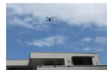
勾配系屋根や太陽光パネルの確認をドローンカメラにて実施(一部エリアではドローンカメラ未導入)
