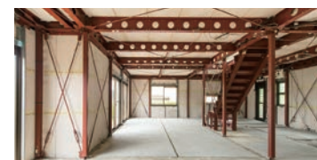
築24年のヘーベルハウス躯体
