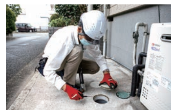
定期点検作業
