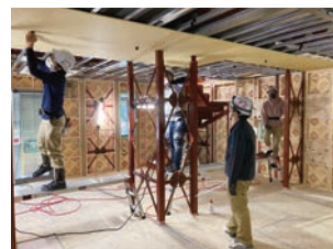
プレハブ建築科内装施工初級訓練
