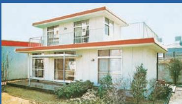
「上質で長持ちする工業化住宅」の提供を目指し、鉄骨、ヘーベル、連続布基礎による構法を採用した戸建住宅「ヘーベルハウス」を販売開始。
