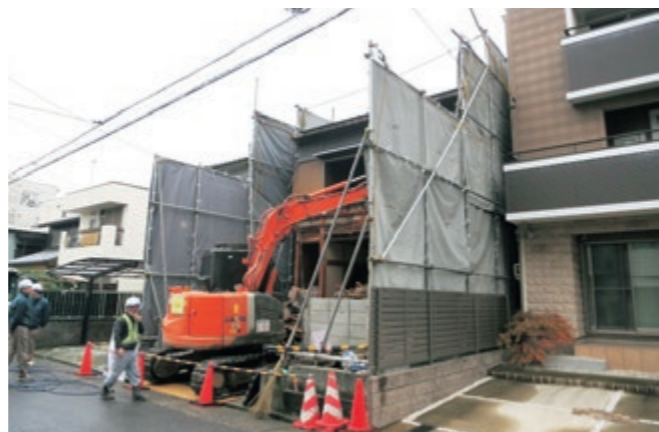
解体工事中の敷地養生状況
