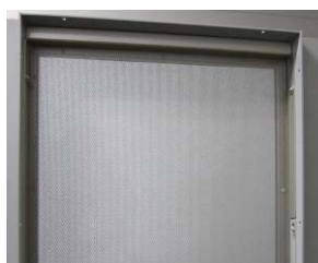
防犯通風スクリーン（面格子の代わりにパンチングメタルで防犯性を確保）
