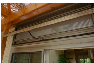
防犯通風窓（ランマにパンチングメタルが入っていて網戸も兼ねる：開発中）
