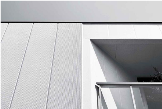
異なる厚みの外壁で濃淡のある陰影を生み出す
