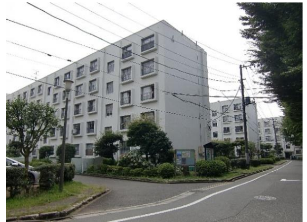
▲向原第二住宅団地外観写真
