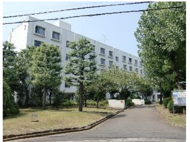
▲向原第二住宅団地外観写真
