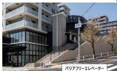
高低差を解消するバリアフリーエレベーター
