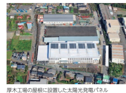
厚木工場の屋根に設置した太陽光発電パネル
