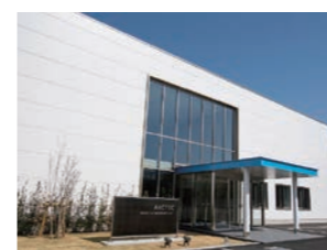
建設技術教育センター外観
