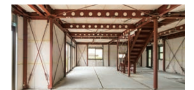
築24年のヘーベルハウス躯体
