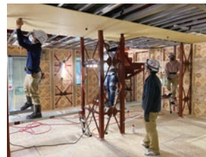
プレハブ建築科内装施工初級訓練
