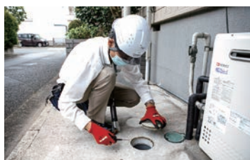
定期点検作業
