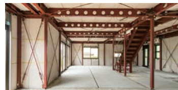
築24年のヘーベルハウス躯体
