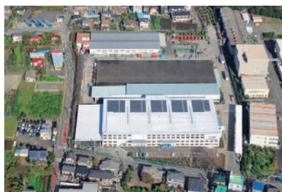
厚木工場の屋根に設置した太陽光発電パネル
