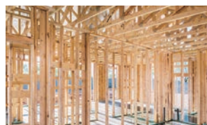
壁材の一部に転用された木材を使用
